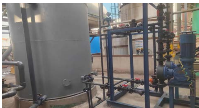
常安能源脱硫废水零排 2# 一体化改造装置
